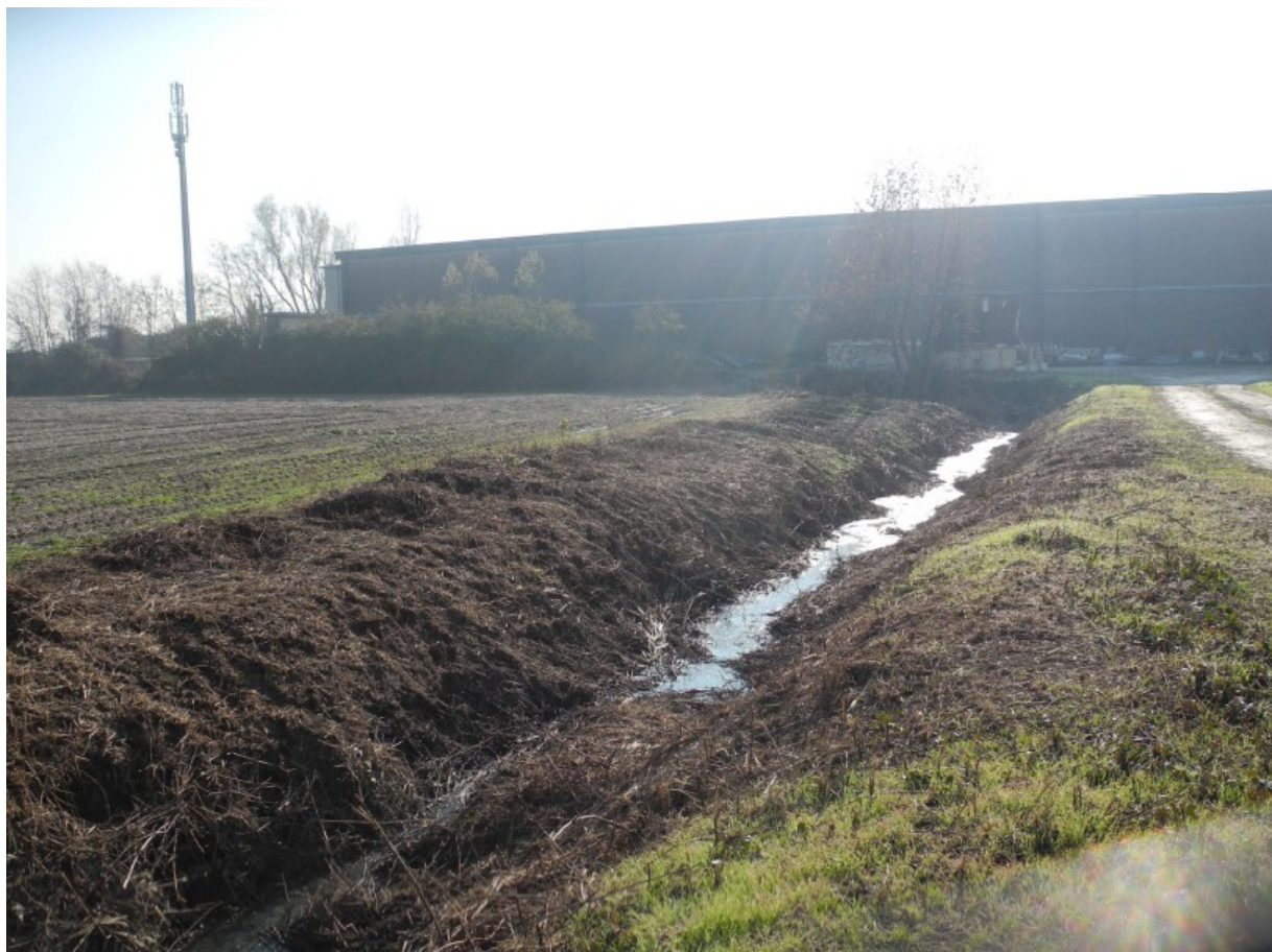
Figura 7: Vista dell'affossatura esistente da spostare sulla cui sede verrà ricavato il nuovo sedime della strada
