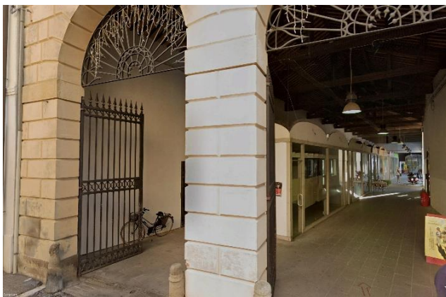
Vista dell'accesso laterale ovest con le unità commerciali esistenti
