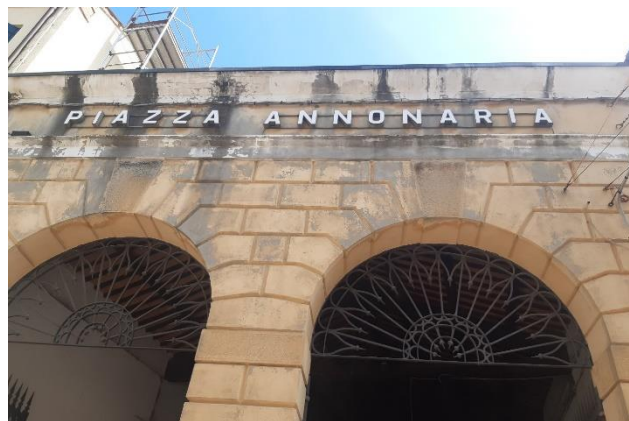
Vista dell'insegna posta sopra l'accesso laterale ovest
