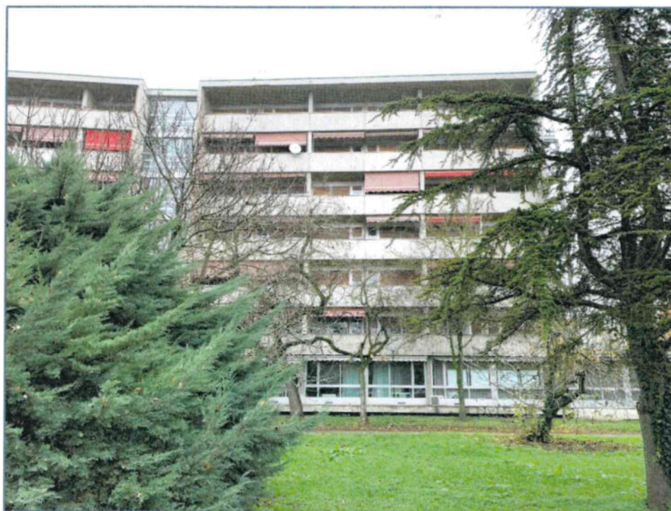
Foto 3. Blocco A: prospetto sud
