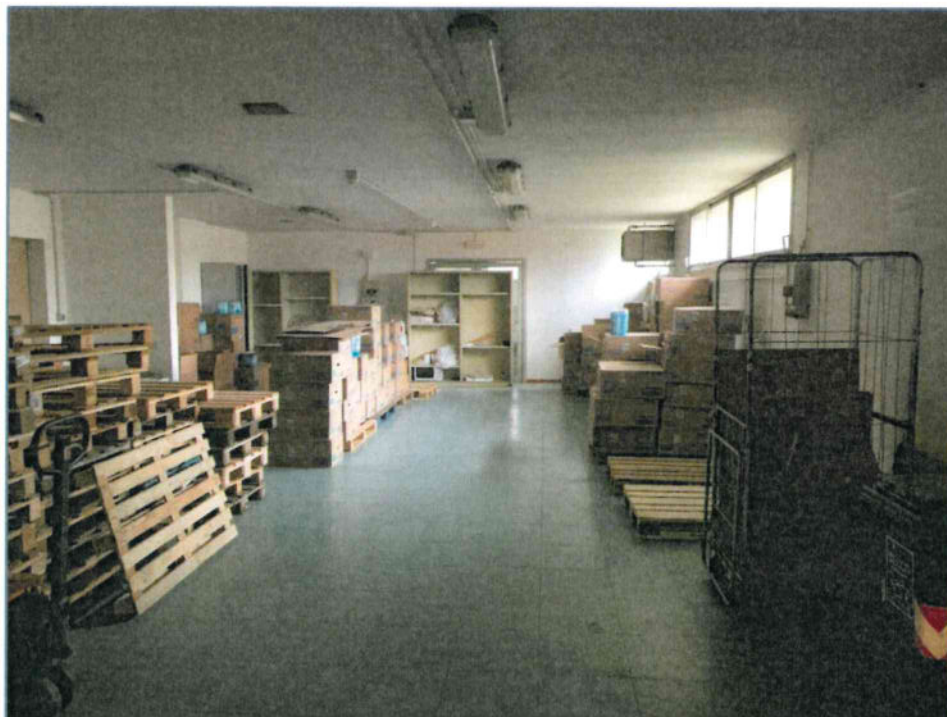
Foto 22. Piano terra – Blocco A: lavanderia
