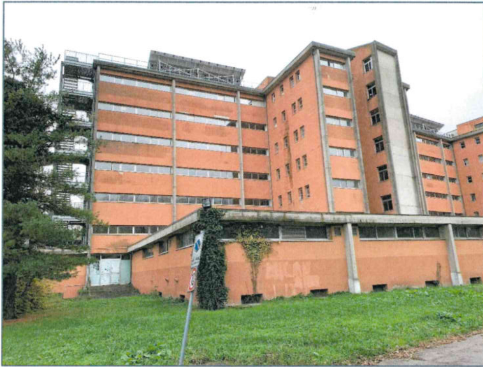
Foto 13. Blocco A e vano scale: vista da nord
