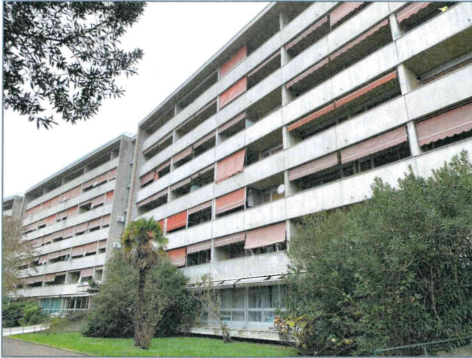
Foto 5. Blocco B e Blocco C: prospetto sud
