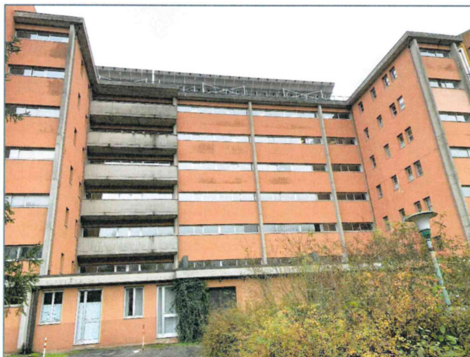
Foto 12. Blocco B: vista nord
