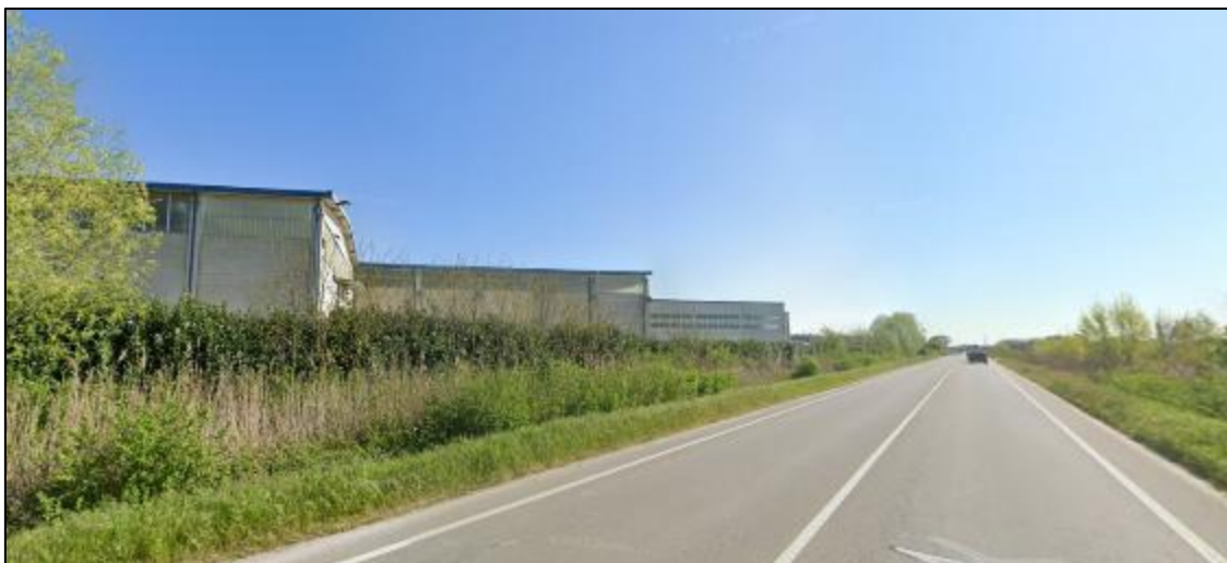
Figura 2.24 – Vista capannoni industriali lungo la SP4 (fonte: Google Street view)
