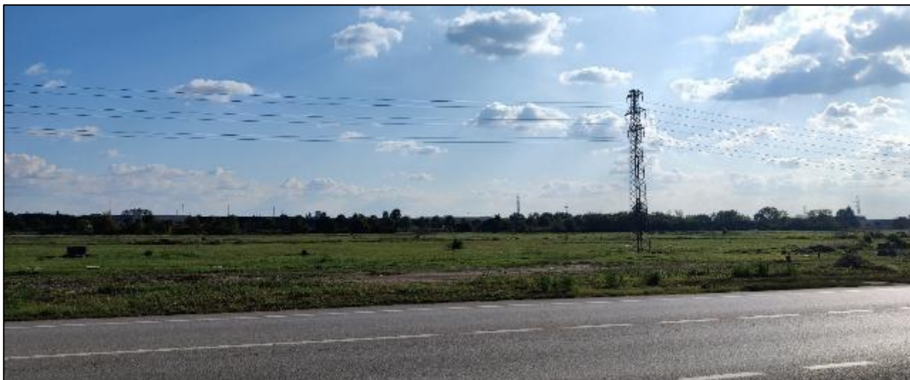
Figura 4.17 – Punto di rilievo fotografico n. 2 – Vista dalla Strada Provinciale SP4. Stato di fatto.
