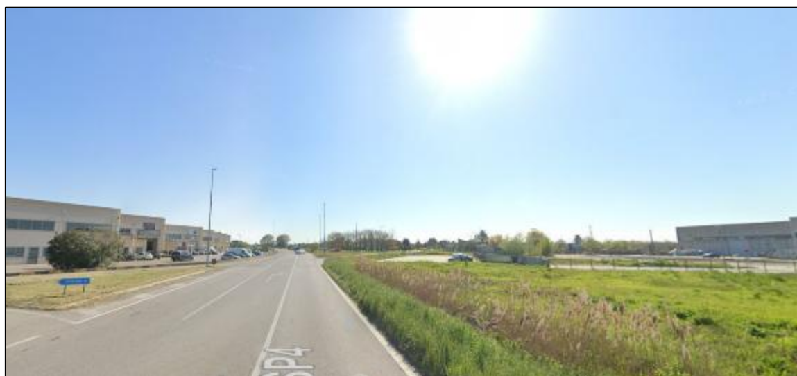
Figura 2.22 – Vista capannoni industriali lungo la SP4 (fonte: Google Street view)
