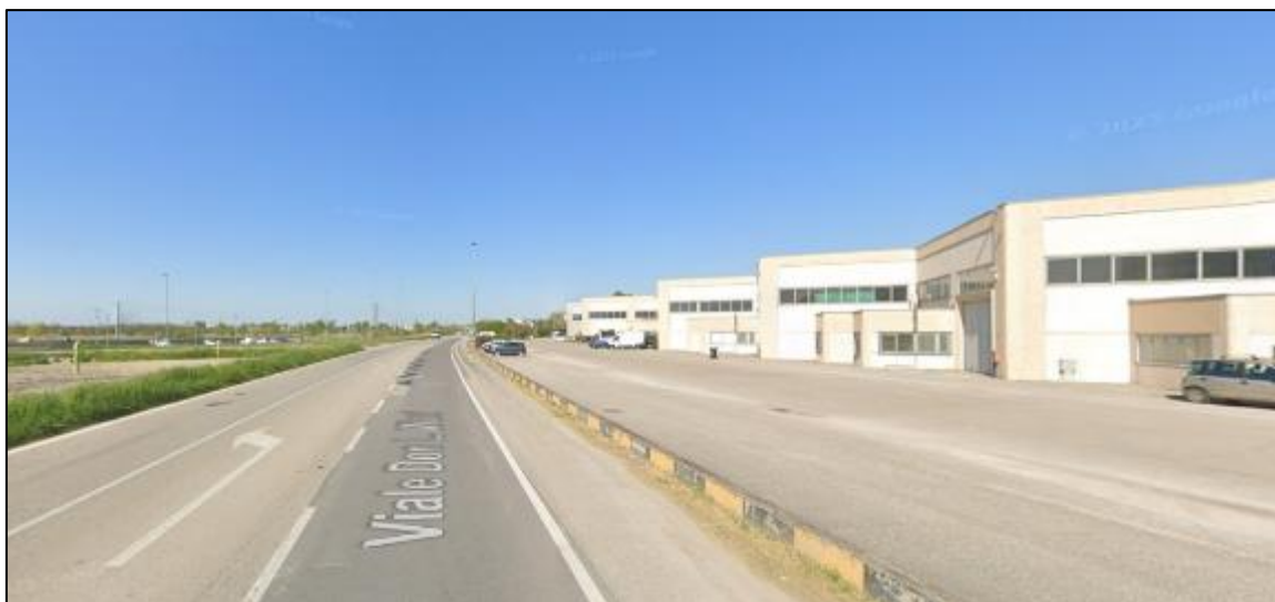
Figura 2.21 – Vista capannoni industriali lungo la SP4 (fonte: Google Street view)
