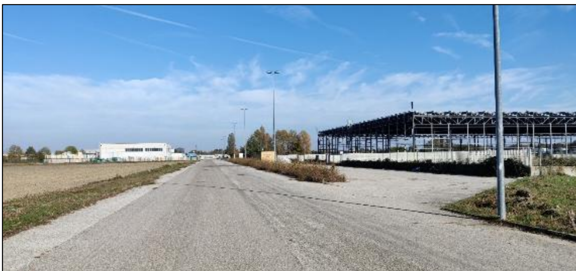
Figura 2.27 – Vista cantieri e capannoni industriali lungo viale Caduti sul lavoro a sud del sito di progetto.
